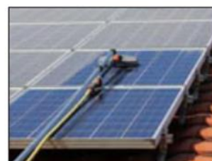
Zonnepaneel reiniging
